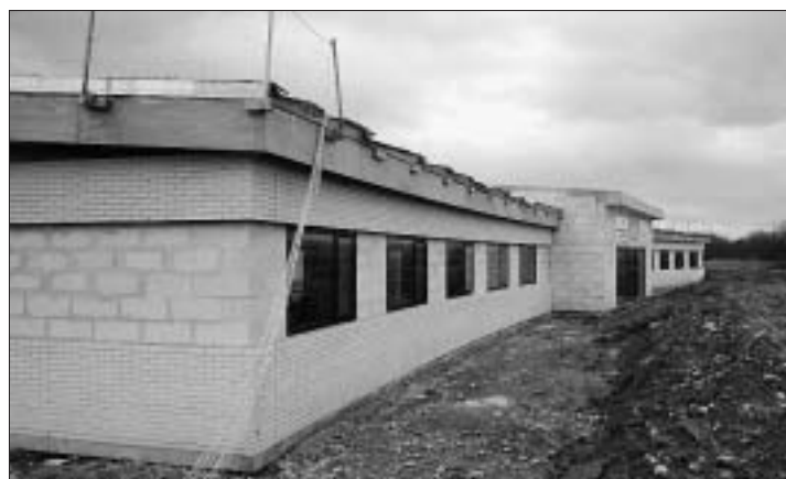
Les travaux de construction de la pépinière d'entreprise ont pris un peu de retard. La structure devrait être prête début juin.
